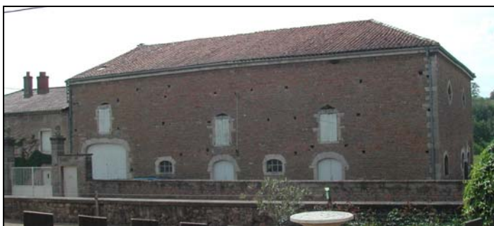
Site n°3- Bâtiments n°1 et 2
